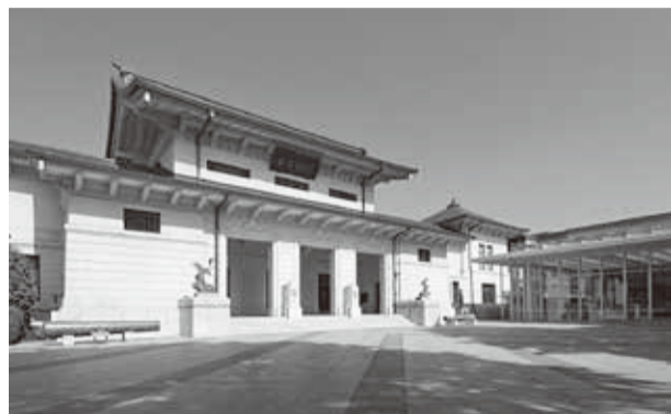
改修工事が進む遊就館
